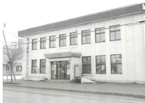
解体前のたいせつ農協鷹栖支所
